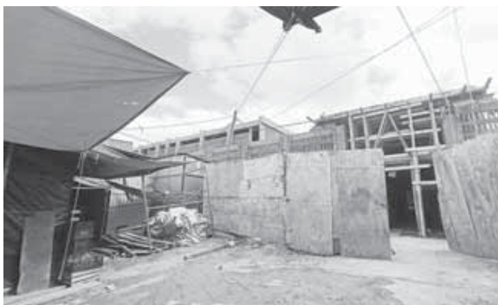
Las obras en la zona de pan de la Central de Abasto, que prometen entregar el 15 de noviembre.
