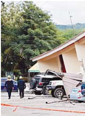
■ Daños en edificios dejados por el sismo en Panamá.
