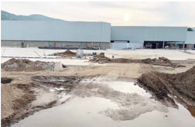
Las obras que concluyeron con la apertura de una tienda departamental en agosto por la zona de Brenamiel.
