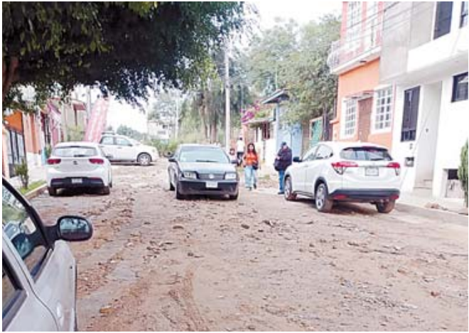
Afectaciones y escombros en las calles de la unidad habitacional El Rosario desatendidos por autoridades de San Sebastián Tutla.
