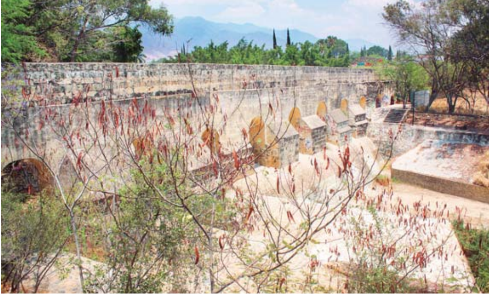
El Acueducto de San Felipe está ubicado en los límites de la colonia La Cascada y el barrio de Xochimilco.
