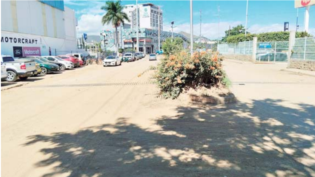
Desde el 19 de agosto “entregaron” la obra, a medias. No ha sido pavimentada, luego de un retraso de 8 meses en la conclusión proyectada.
