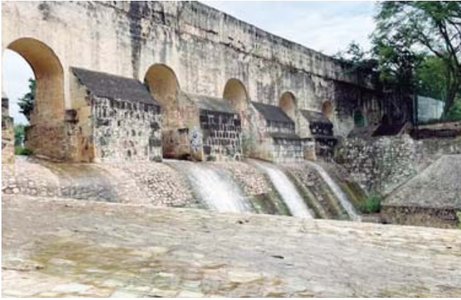
El proyecto consiste en la limpieza y retiro de vegetación invasiva, suciedad y otros.
