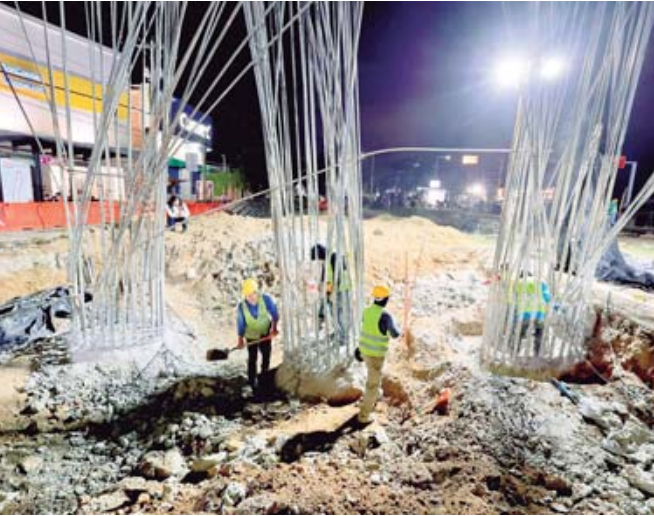
Cimentación para el distribuidor vial de Viguera.
