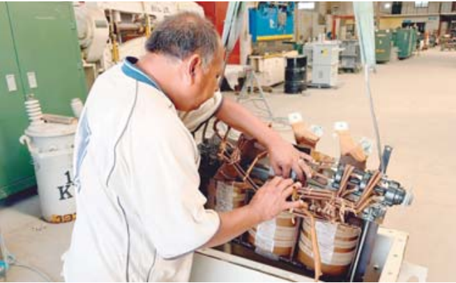
Trabajos de rehabilitación del transformador que abastece de electricidad a las máquinas de bombeo de agua de la colonia Estrella.
