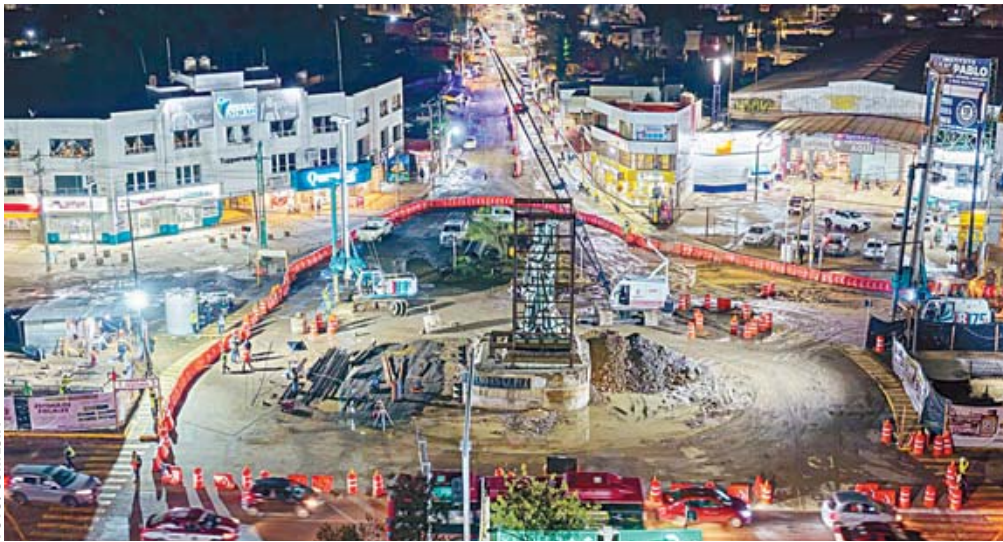
Avanzan las obras del distribuidor vial en Viguera.
