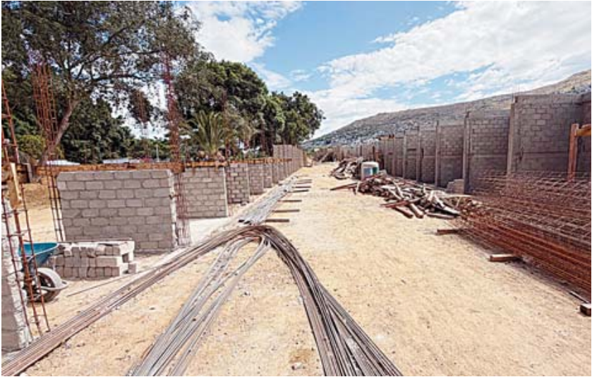
■ Avanza la construcción de los nuevos locales en las Riberas del Atoyac.
