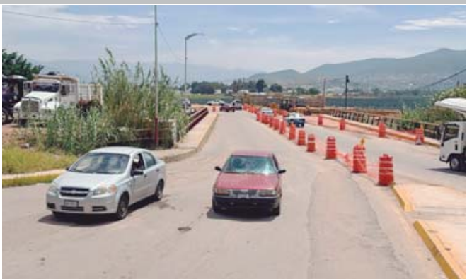
■ Obras en el libramiento de la ex garita
