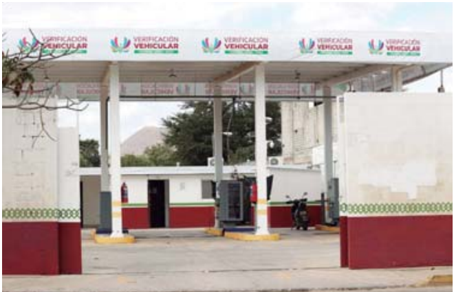
Apenas han verificado emisiones contaminantes 1 de cada 10 autos en Oaxaca.
