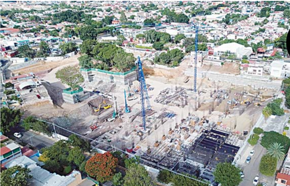
Persiste el incesante trabajo de maquinaria pesada en el predio de la obra de Fibra Danhos.
