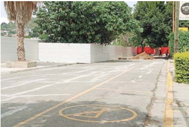
Desde hace semanas las grietas en el asfalto han sido parchadas.
