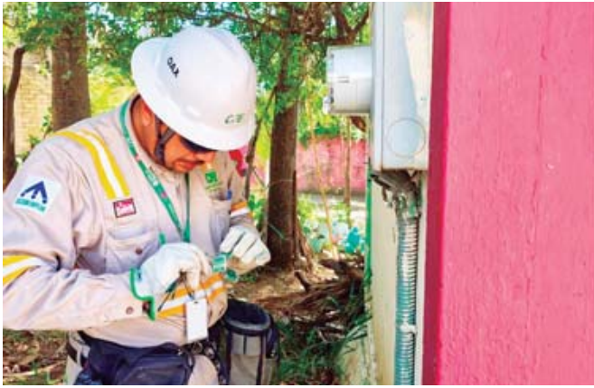
■ Cambio de fusibles para el rebombeo de agua.
