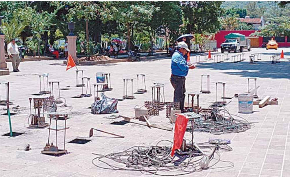
■ Este miércoles ya estaban siendo intervenidas por una cuadrilla de trabajadores.
