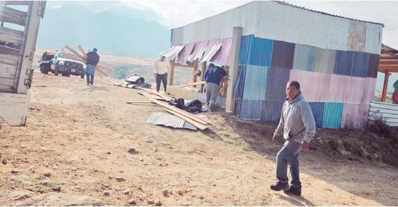
Maquinaria pesada y estructuras provisionales instaladas por integrantes de la agrupación ASAEO fueron localizadas dentro del terreno en la colonia La Loma.
