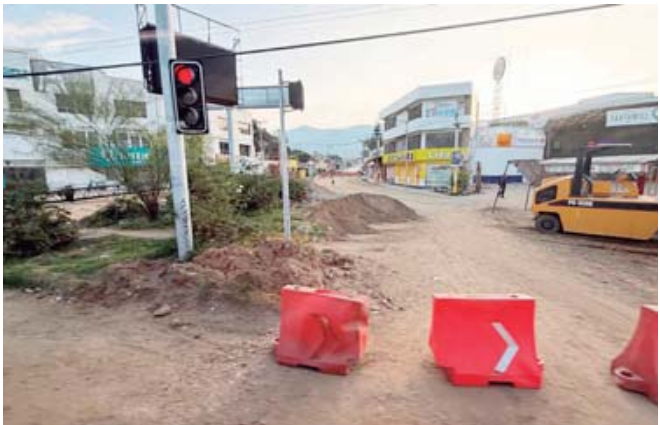
■ Se destacó el banderazo de inicio para la construcción del paso a desnivel en la carretera federal 190.
