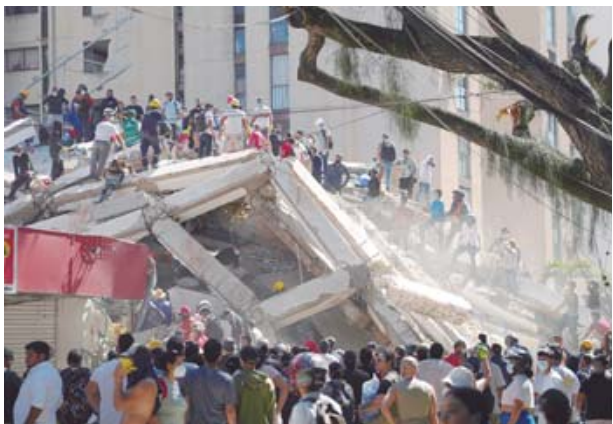
■ Equipos de emergencia de distintas regiones fueron movilizados para apoyar las labores de rescate.
