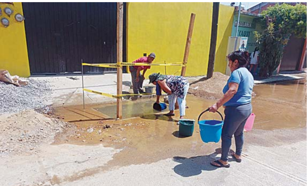
■ Una fuga de agua en la colonia Gómez Sandoval.
