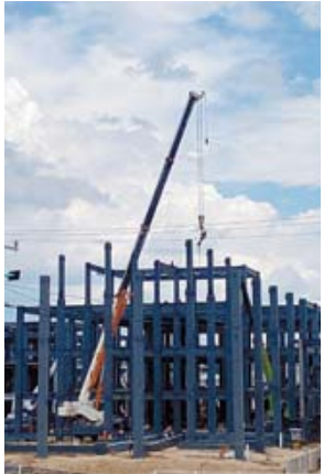
■ La obra civil del ISSSTE en Ciudad Salud.
