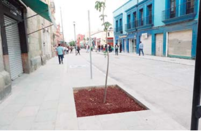
Se observa la falta de rejas en las bases de varios de los árboles plantados.
