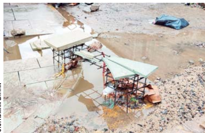
Ante lluvias intensas, suelen generarse inundaciones, deslaves y caída de árboles.
