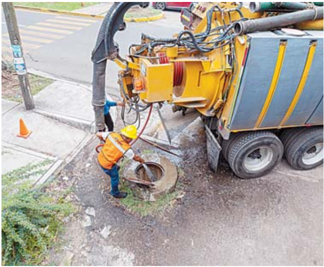
Emplean una flotilla de equipos vector para el mantenimiento de la red de drenaje.
