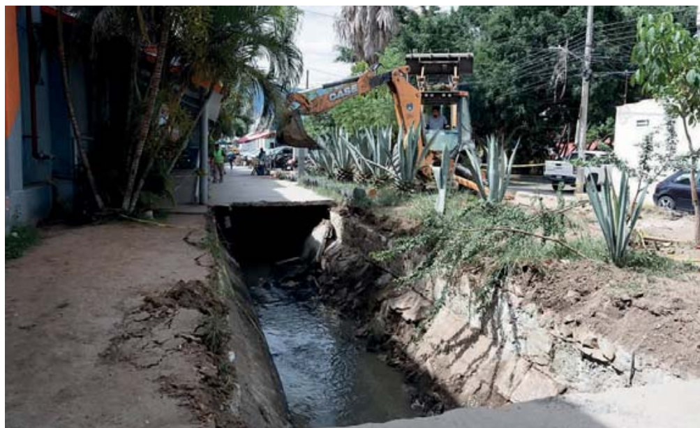
■ El andador del Sol es una vialidad que también funciona como entubamiento del canal de aguas pluviales en la zona.
