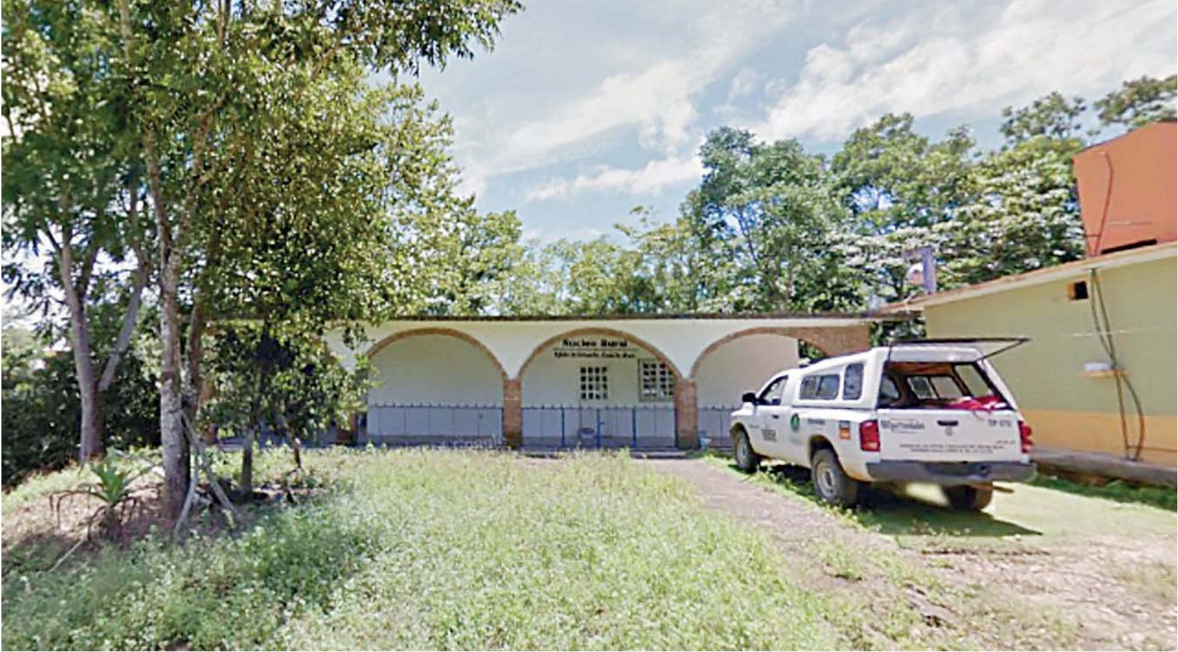
La limpieza de pozos implica peligros letales si no se cuenta con el equipo adecuado, monitoreo de gases, ventilación o personal capacitado.
