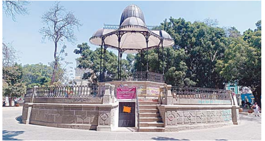
En las últimas semanas se ha retirado el piso en el que se habían registrado filtraciones.
