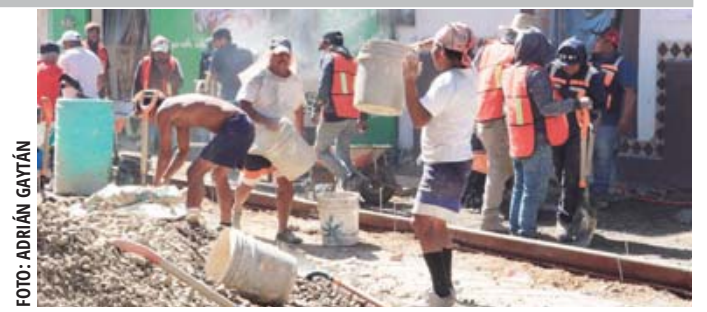
Se intensifican los trabajos de rehabilitación de la calle Miguel Cabrera.
