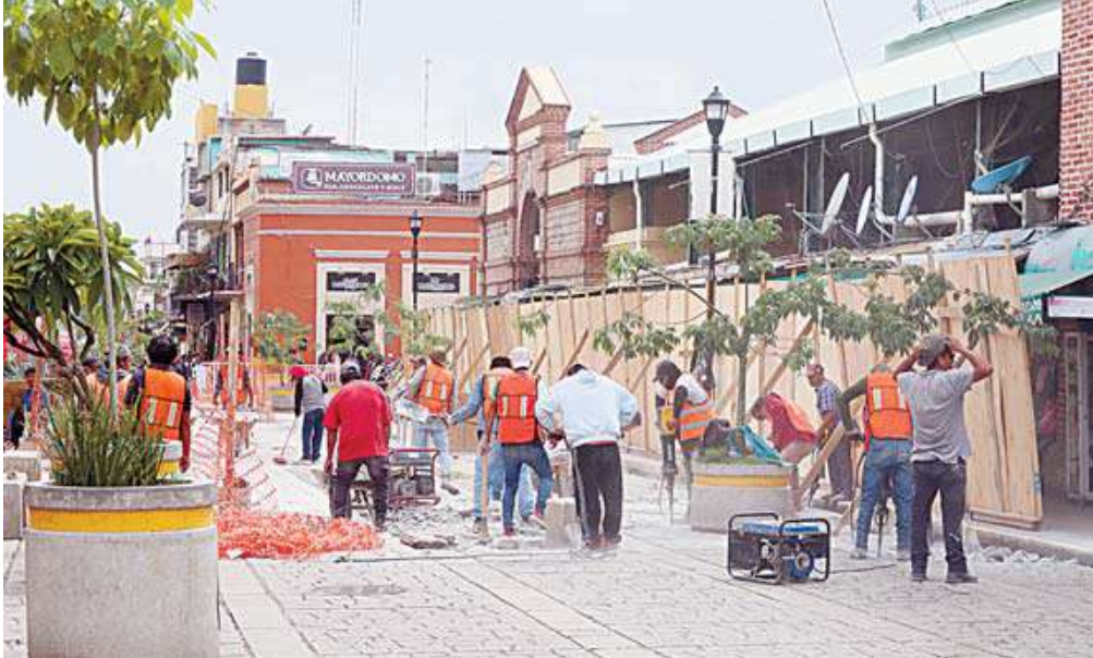
FOTO: LUIS ALBERTO CRUZ ■ Iniciaron los trabajos en la segunda calle de Flores Magón del programa Oaxaca Camina.
