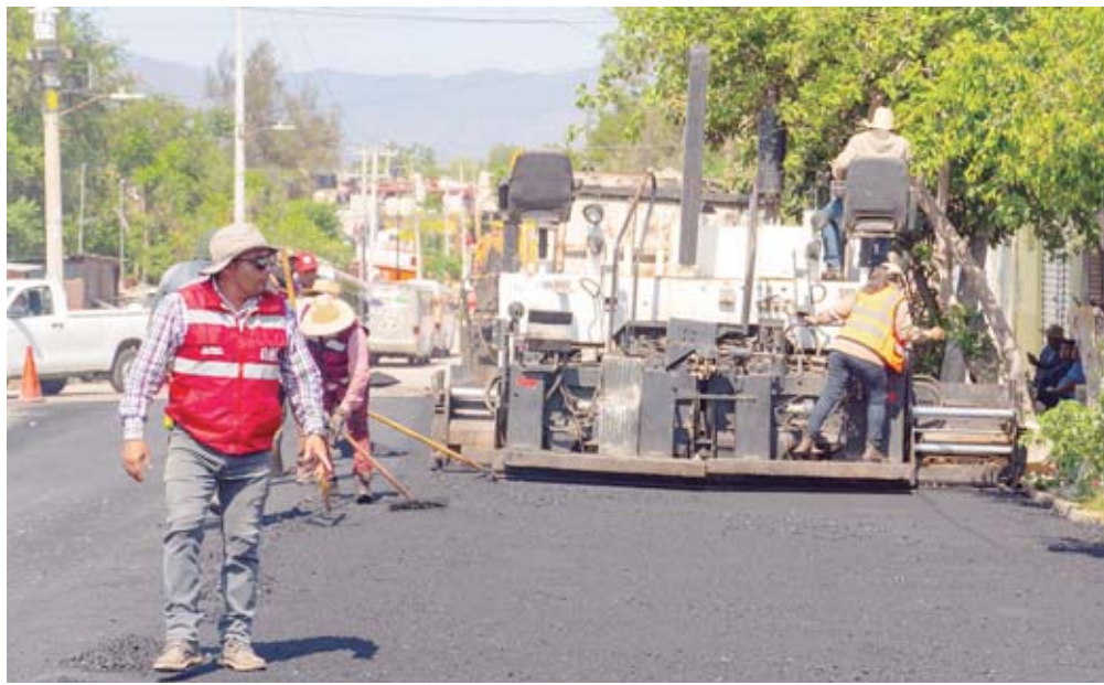
■ Pavimentación en la calle Río Verde, en el tramo Río Grijalva - Av. Central Norte - Sur en la Unidad habitacional Ricardo Flores Magón.
