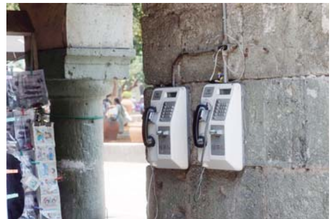
Los aparatos, prácticamente obsoletos, incrustados en edificios.
