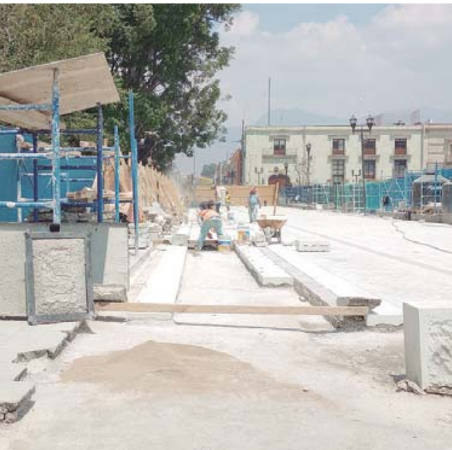
■ Ya está la primera etapa de la rehabilitación de la Alameda de León.
