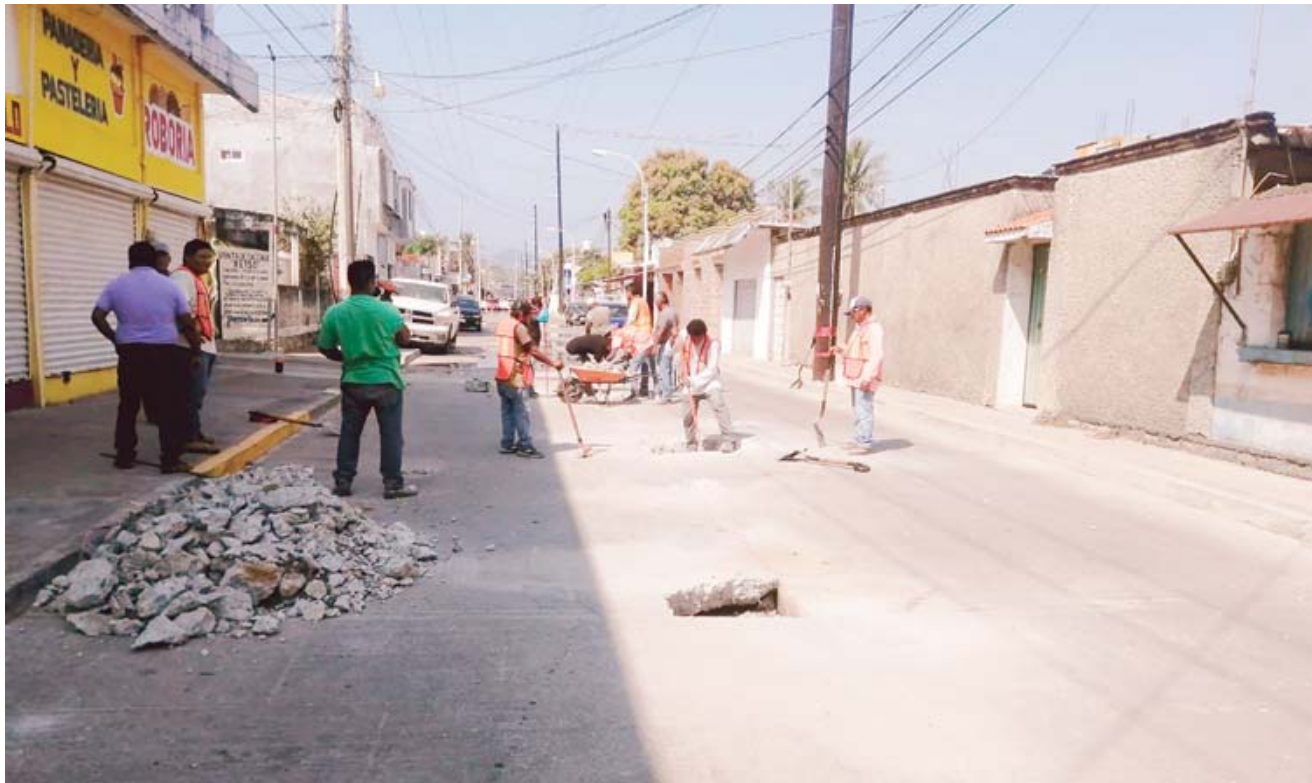
Los pobladores demandan trabajos de calidad.
