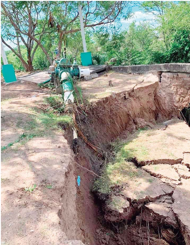
► Se registró hundimiento de la estructura en el muro de contención del pozo 6 ubicado sobre la carretera Juchitán-Espinal.
