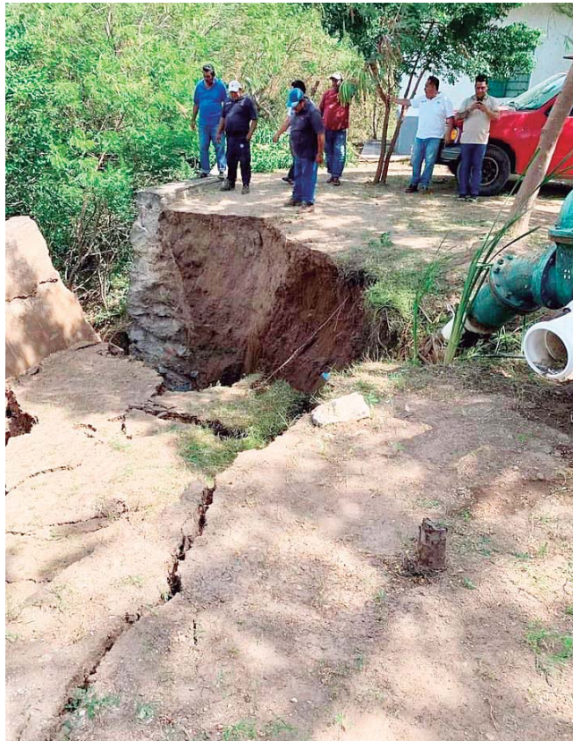
► Se registró hundimiento de la estructura en el muro de contención del pozo 6 ubicado sobre la carretera Juchitán-Espinal.
