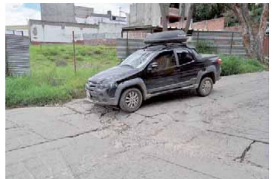
Los hundimientos, baches y fracturas son muestra del daño en esta vía.
