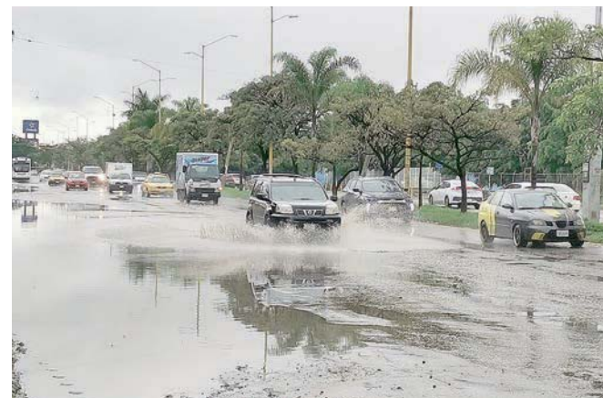
En Avenida Universidad permanecen algunos encharcamientos.
