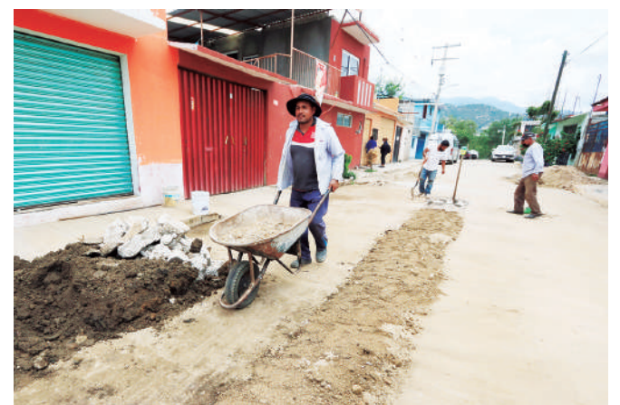
■ Es indispensable reemplazar la infraestructura, que ya está obsoleta.
