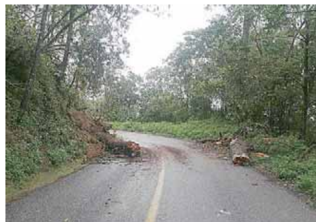
► Las carreteras presentan afectaciones.
