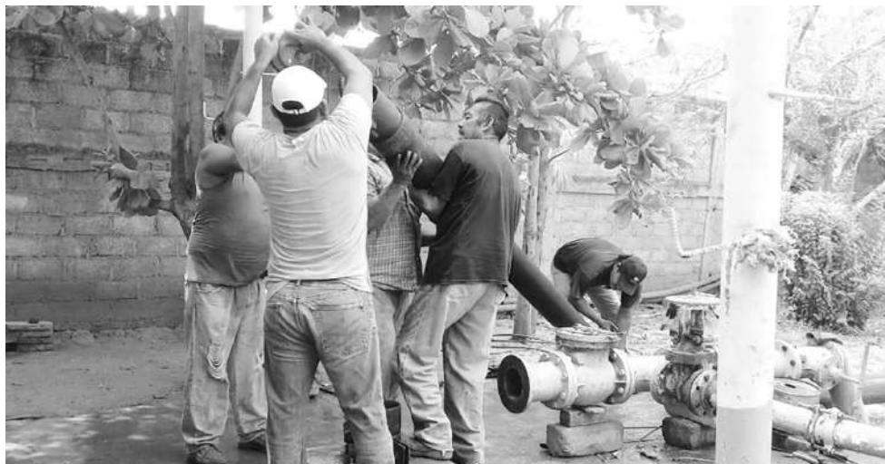
► Las fallas eléctricas han afectado en varias ocasiones al sistema de agua potable de Juchitán.
