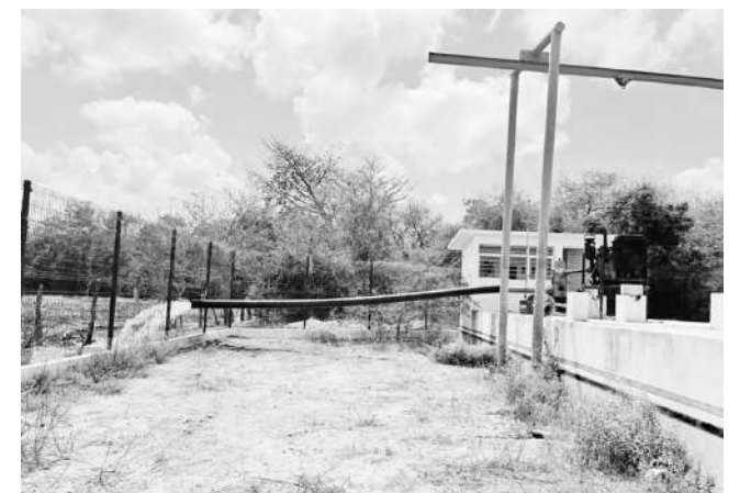
► Los pozos se encontraban originalmente en manos de particulares.
