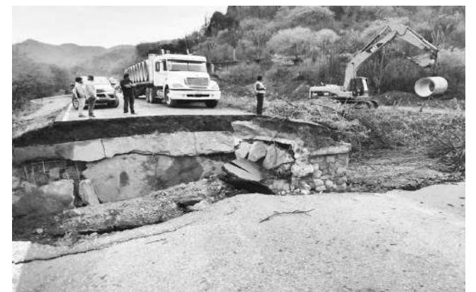
► Las lluvias han dañado las carreteras en la Mixteca y la Cañada.
