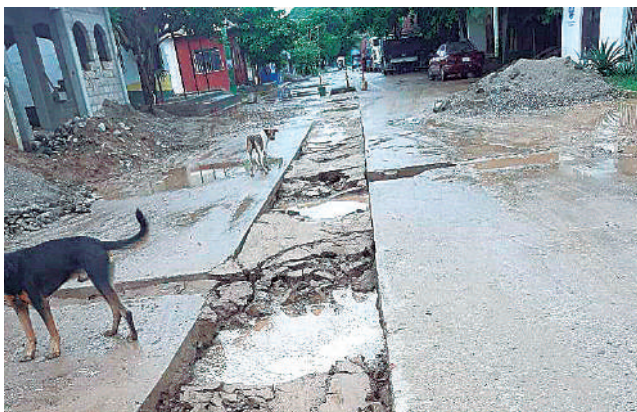
► En otras colonias los ciudadanos también denuncian la falta de atención de obras.
