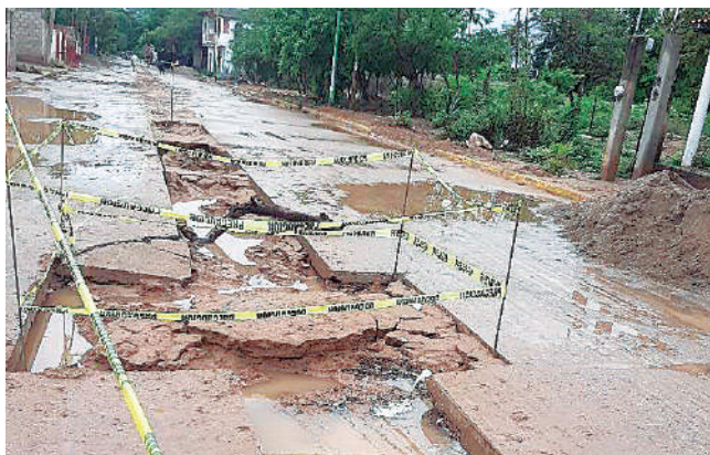
► La ciudadanía señala que el pavimento alrededor del drenaje se está hundiendo.
