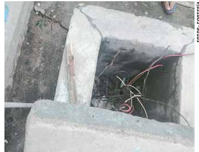
▶ Destrozan el cableado.
