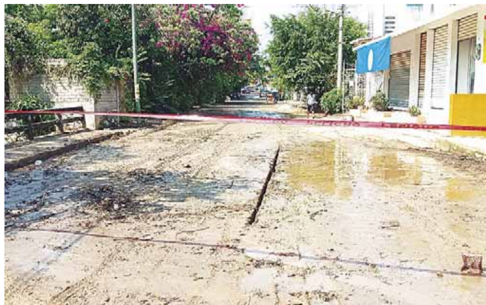
► En el Barrio El Panteón hubo daños en viviendas y en la pavimentación de la calle.
