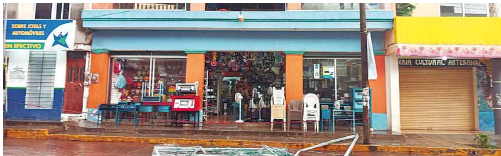
► Vidrios de un ventanal quedaron esparcidos en la carretera.
