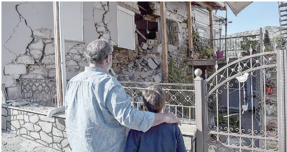
► Las autoridades evalúan los daños causados por el sismo.
