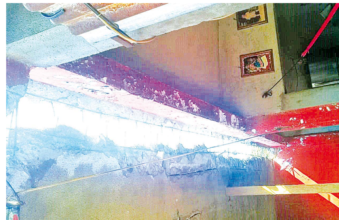
► Los daños estructurales en algunas viviendas son evidentes.
