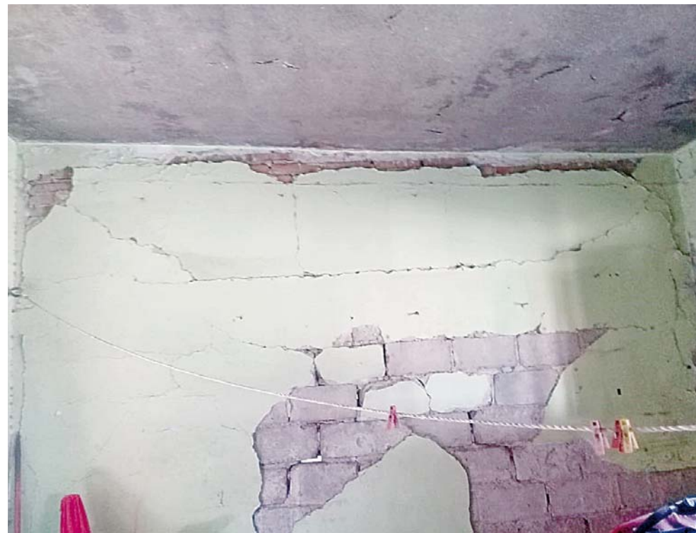
► Las viviendas de niños y jóvenes con discapacidad también permanecen con daños.
