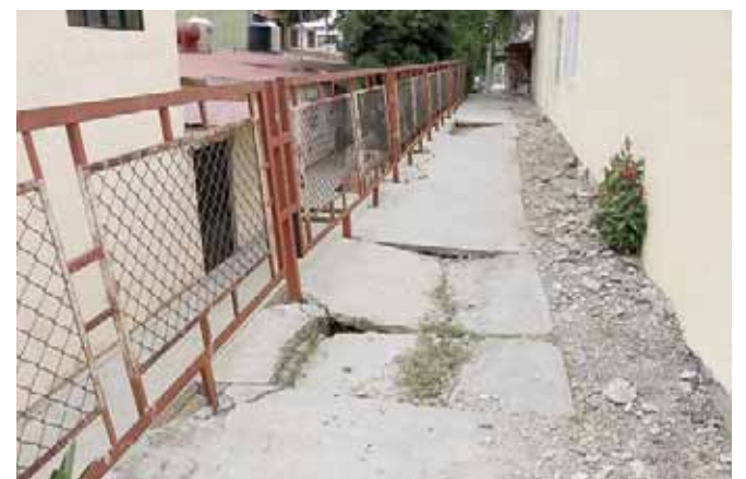
► Se han detectado varias fracturas en banquetas, escaleras y barandales.
