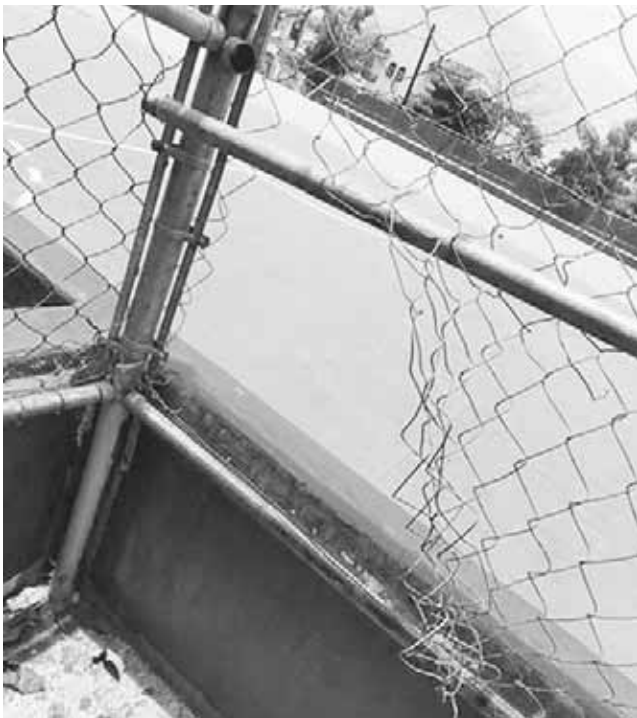
► El deterioro es evidente.
