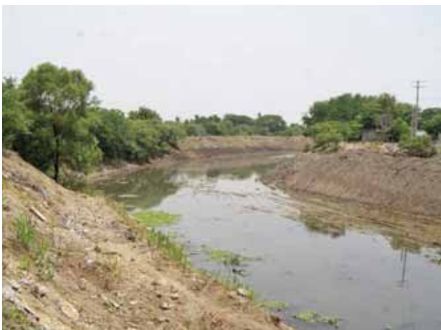
► En Juchitán realizan trabajos de desazolve en río Los Perros.
