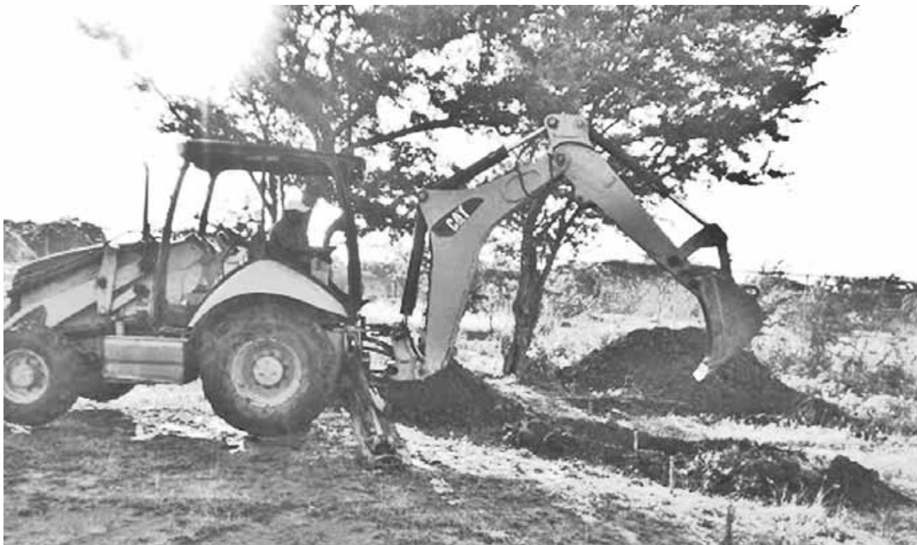
► Este viernes se realizarán los trabajos de excavación.
