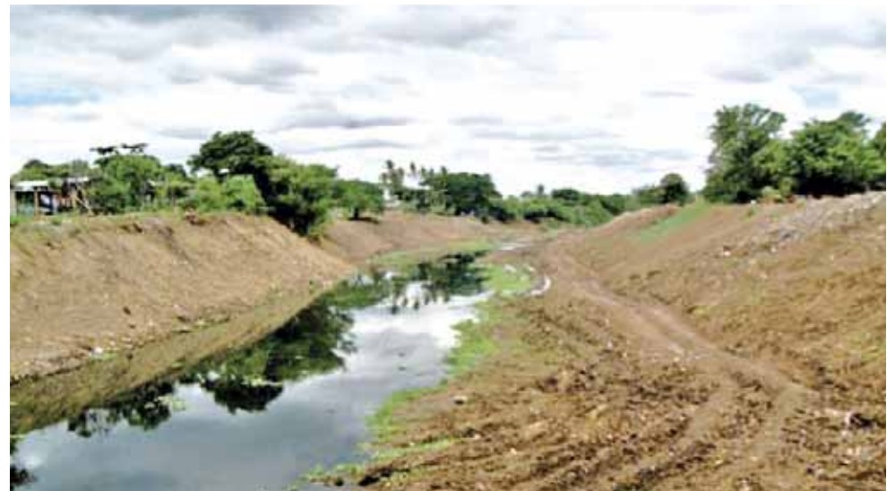
► Se espera que 21 kilómetros lineales sean desazolvados.
