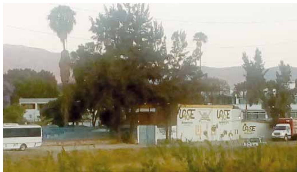
► La zona carece de seguridad o vigilancia lo que supone un riesgo para los estudiantes y transeúntes.
