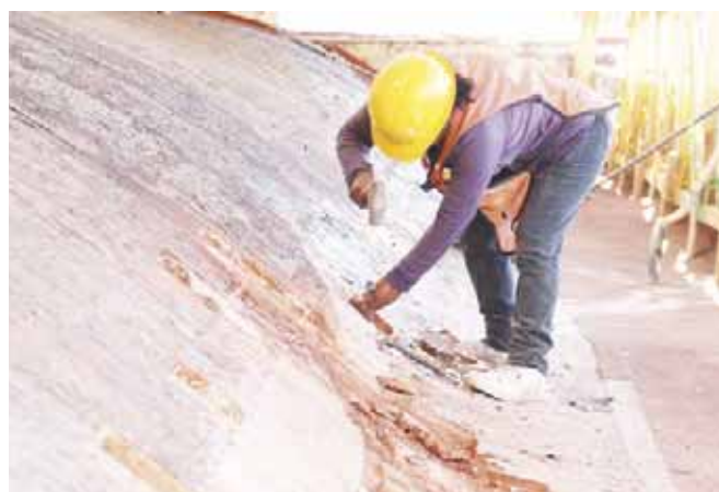
► La mano de obra es limitada.
