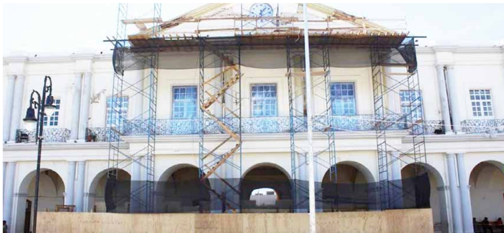
► El palacio municipal sufrió severos daños por el terremoto del 2017.
