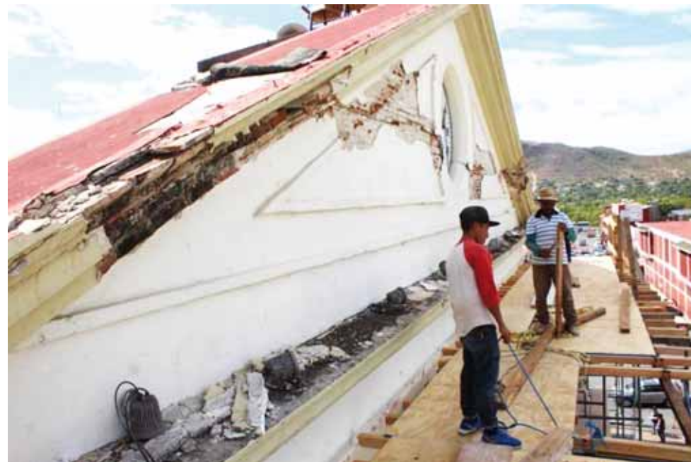
► Buscan conservar sus detalles tal como fue construido.
