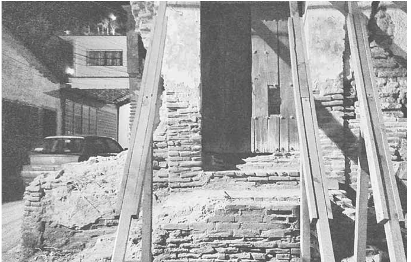
► Grietas y desprendimientos fueron las principales afectaciones.
